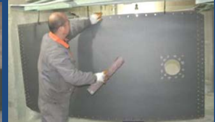
INSPECCION DE ACABADO DE MATERIAL PREVIO A RECUBRIMIENTO
