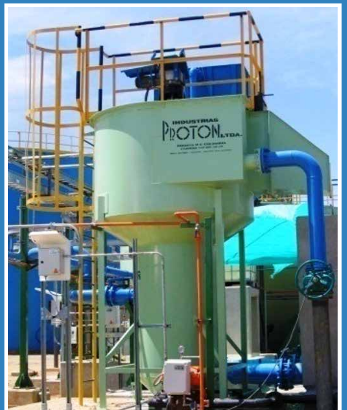
DESARENADOR TIPO VORTEX
