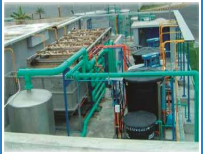
CELDA DE FLOTACIÓN- DAF
