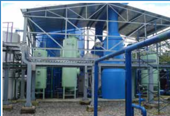
DESMINERALIZACIÓN AUTOMÁTICA
